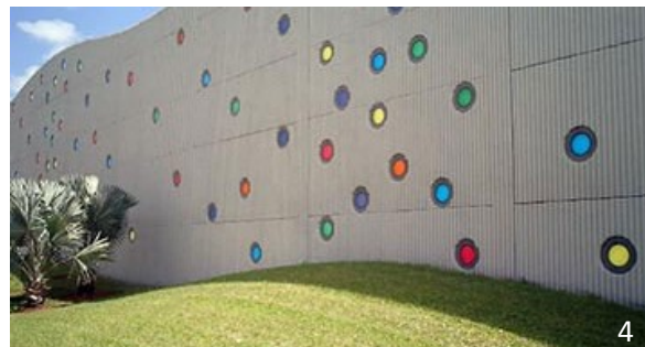
126. attēls. Trokšņa sienas piemēri. Avoti: 1.- urbangreenbluegrids.com , 2.- ausg.com.au , 3.- fao.org , 4.- statecontracting.com .
